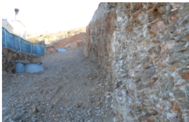
Obres en Finestrelles. La opertura d'un carrer deixa al descobert varies mineralitzacions.
